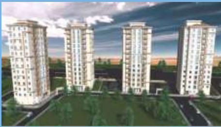
Özdemir İnşaat Beykoz Konakları / Gaziantep
